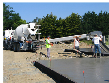
Chantier avec camion-tapis © EDYCEM
