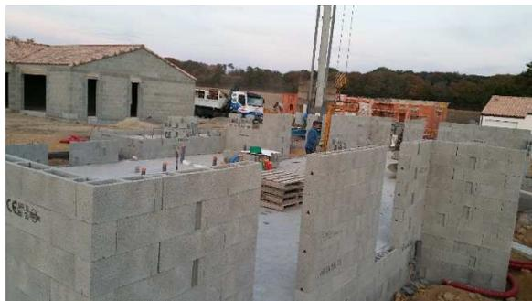
Murs en élévation VERTICAL BLOC® EDYCEM PPL
